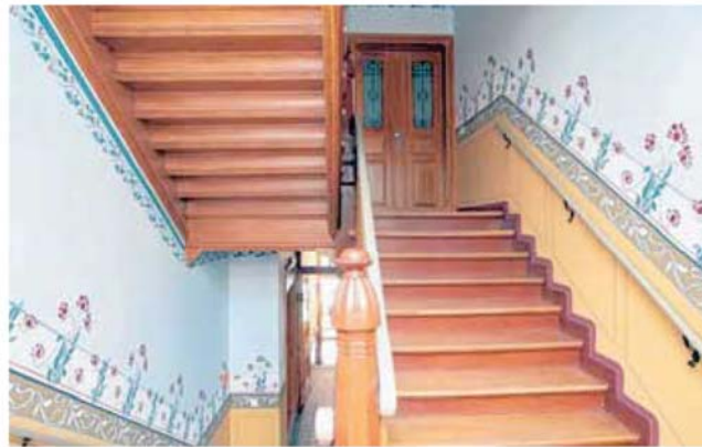
Die Treppenhäuser erhalten nun jene Bemalung zurück, die sie zur Erbauungszeit der Häuser zwischen 1900 und 1910 bekamen.
